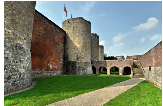
Château de Péronne, moat before intervention
