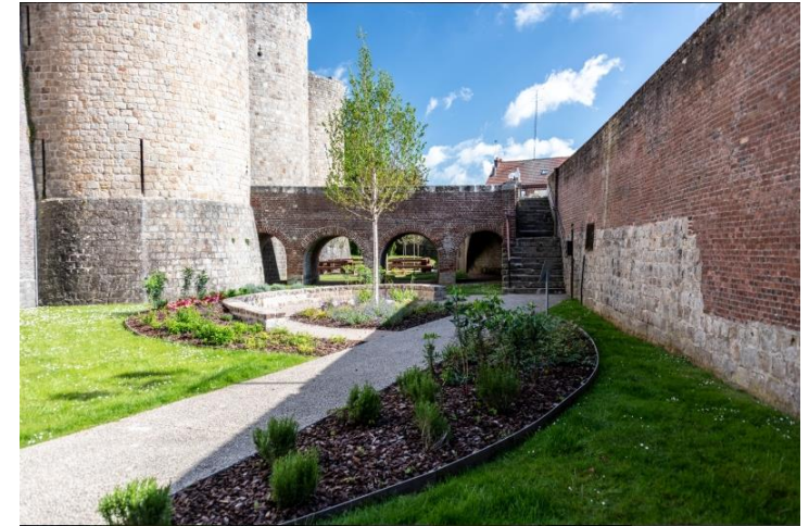
Château de Péronne, moat intervention
